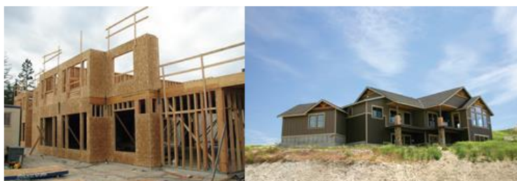
Figura 1 - Exemplos da aplicação do Wood Frame na construção de residências
