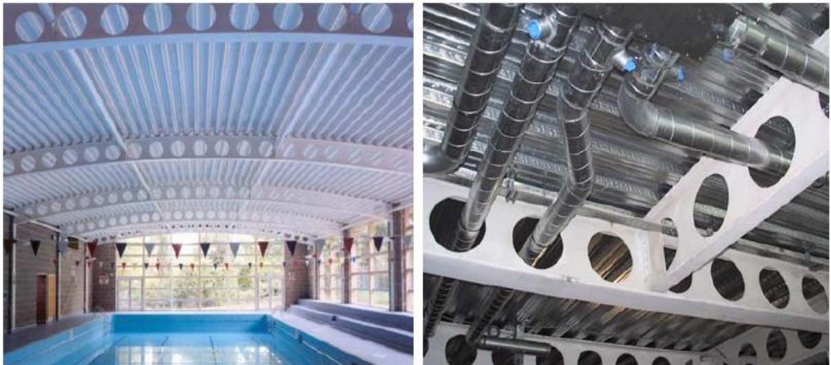
Figura 3 – Vigas celulares permitem vencer grandes vãos e facilitam a integração com instalações e sistemas de forro
