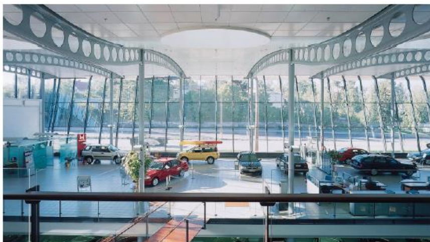
Figura 4 – Aspecto estético das vigas celulares, que conferem um grande apelo arquitetônico
